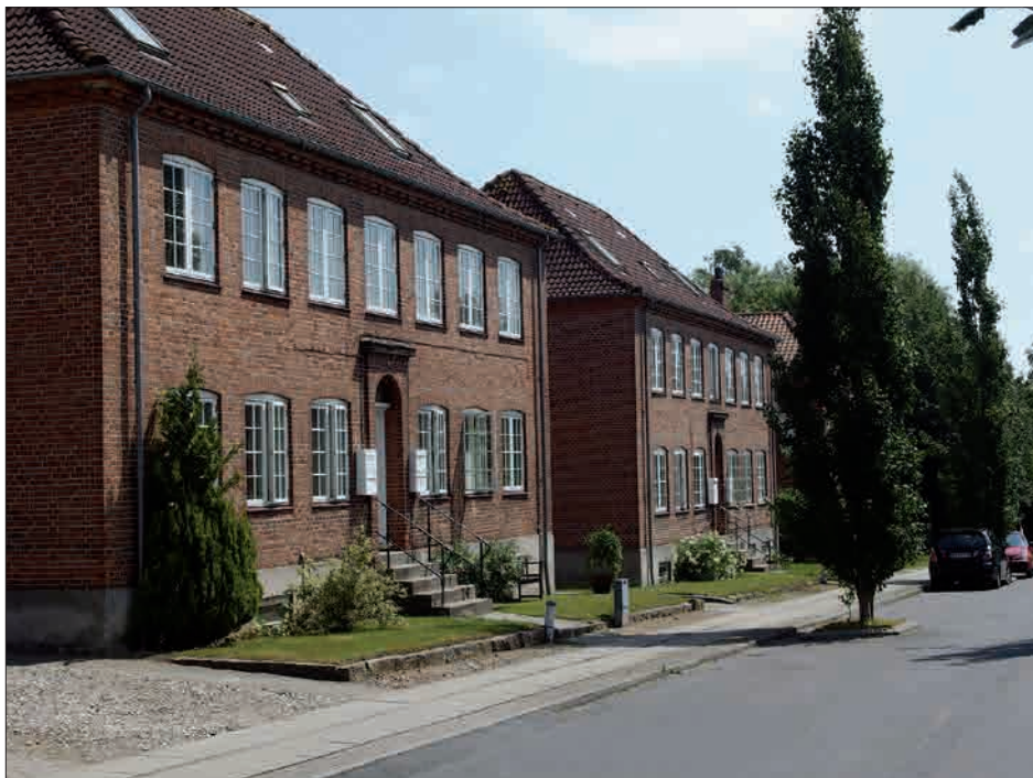
Fig. 7. Firefamiliehusene i Aarsleffsgade 2016. Foto: Forfatteren.
