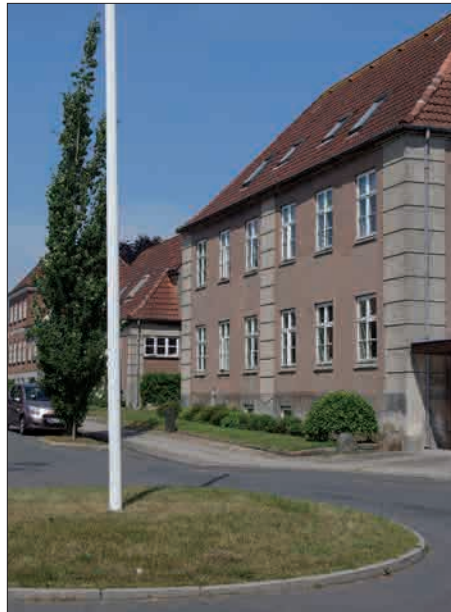
Fig. 6. Aarsleffsgade 2016. Foto: Forfatteren.
